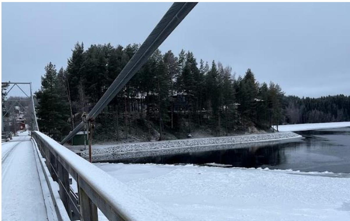
Foto från platsbesök, vy från vägbro riktad mot befintliga fågelnästen. Fågelnästen med höjd under trädtopparna knappt synliga bland träden.
