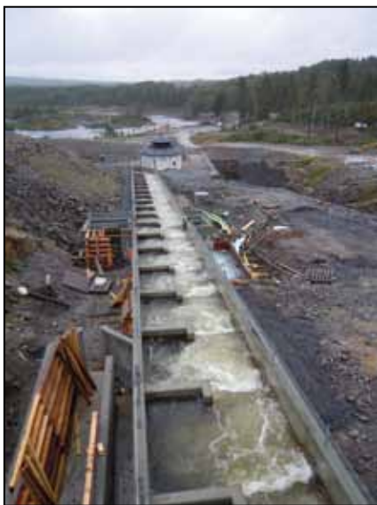
En ny laxtrappa togs i drift vid Norrfors regleringsdamm 2010. Foto: Stefan Ågren
